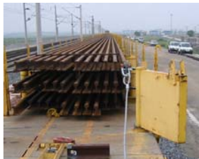
Acopio de carril
