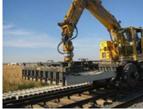
Colocación de traviesas
