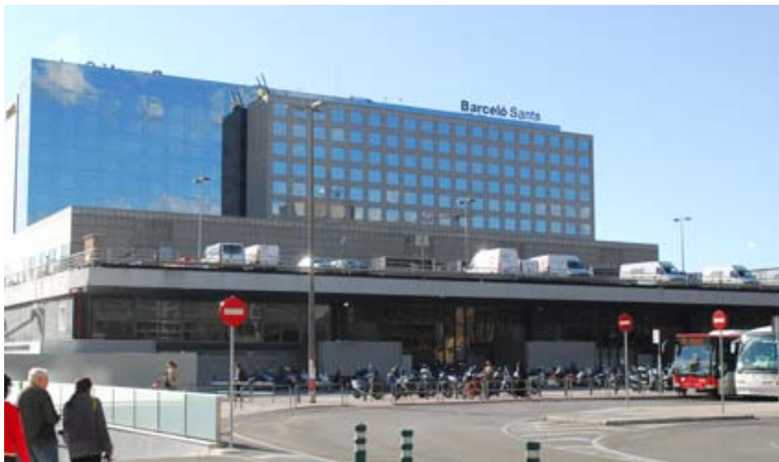
Fachada principal de la estación de Barcelona Sants
