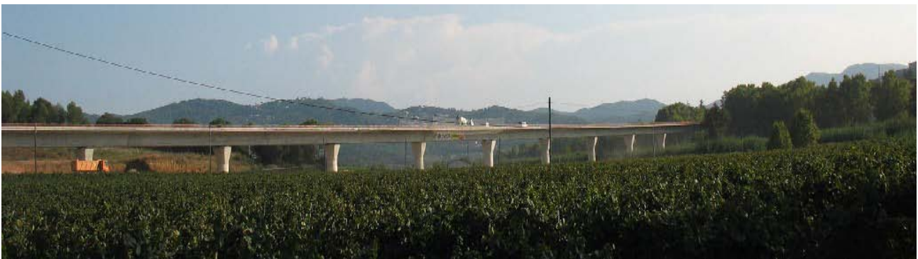
Viaducto del Torrent de Valldoriolf
