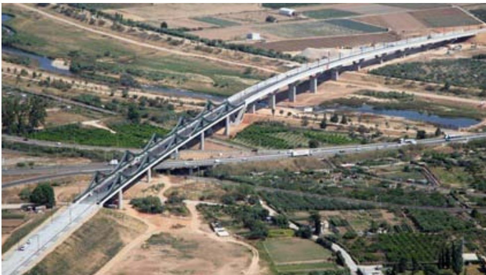
Viaducto de San Boi
