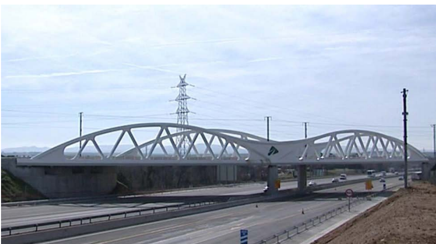
El viaducto de Riudellots
