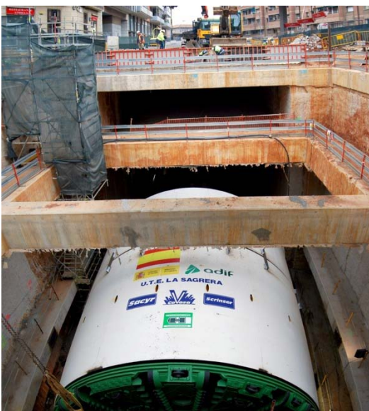
Tuneladora Barcino durante las obras de construcción del túnel Sants La Sagrera
