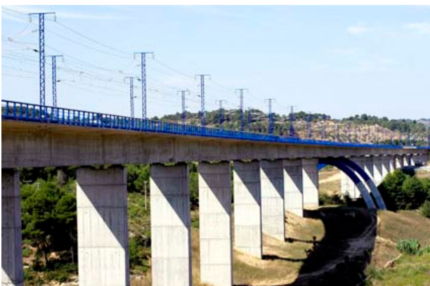
Viaducto de Vinaixa
