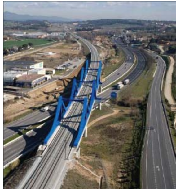
Viaducto de Llinars (574 m)
