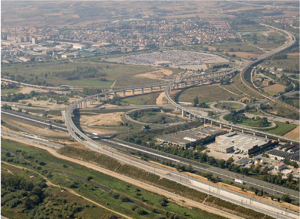
Imagen aérea del nuevo Nudo ferroviario de Mollet
