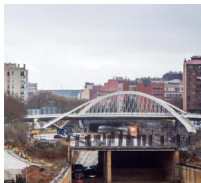
Zona de obras de La Sagrera
